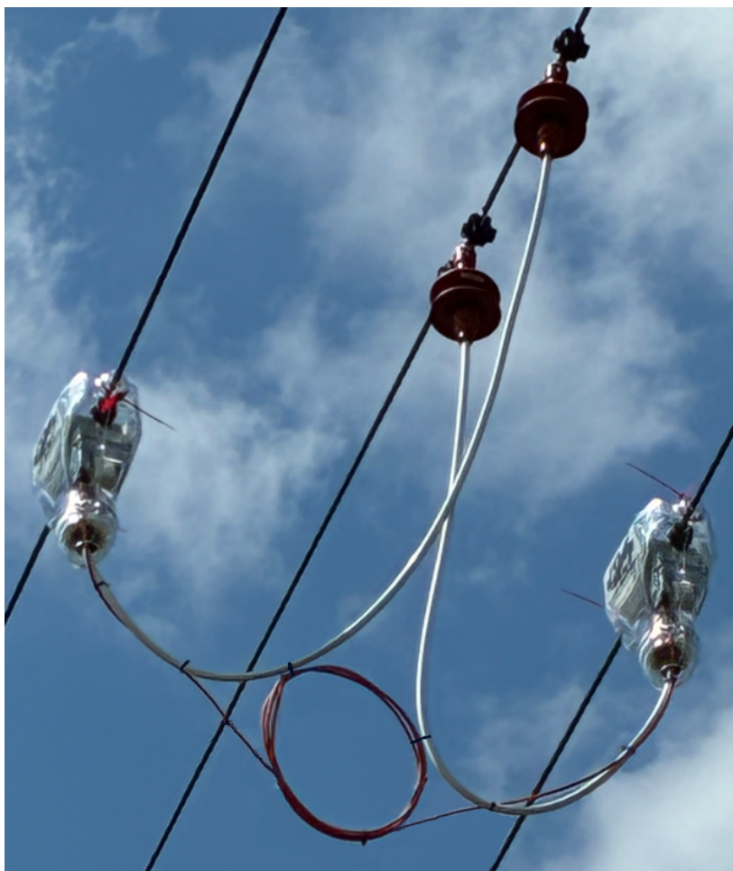
Рисунок 4.17 – Пример смонтированного ИПУЭ
